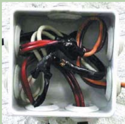
Instalación sin Nylbloc™
